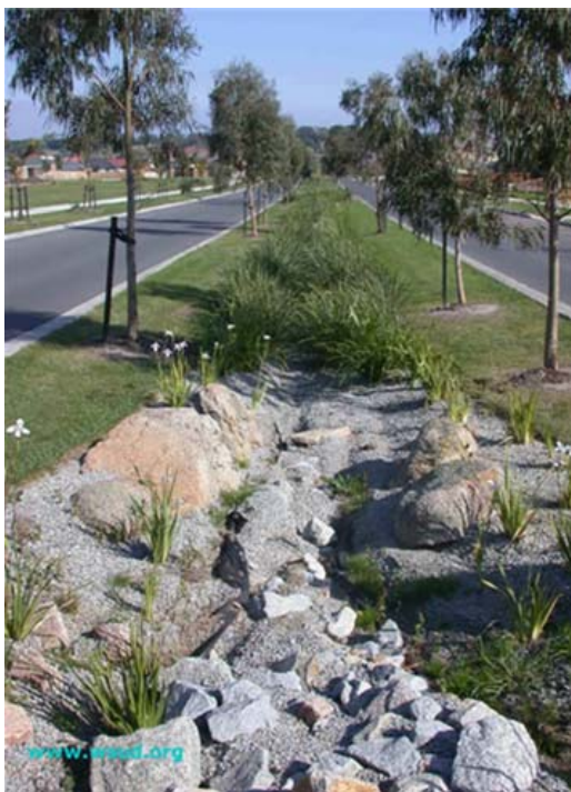
Figura 295. Trincheira de infiltração em canteiro central – WSUD
