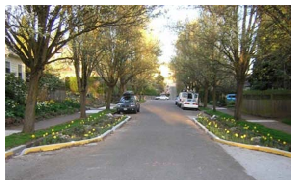
Figura 298. Trincheiras ou poços de infiltração na via pública – cidade de Seattle – EUA
