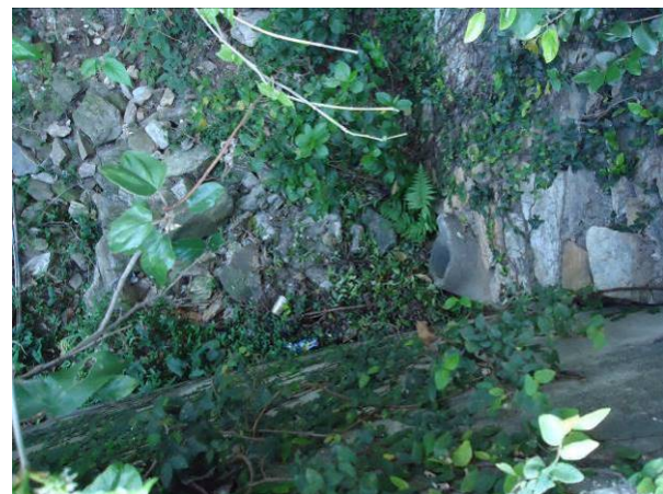
Figura 217. Vista do ponto de lançamento de água pluvial P4
