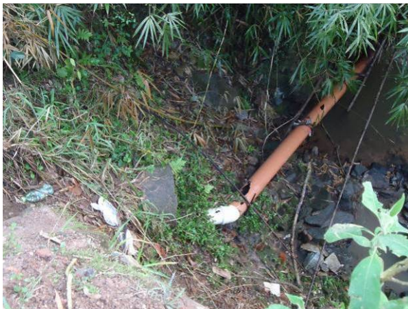
Figura 220. Vista do ponto de lançamento de água pluvial P7
