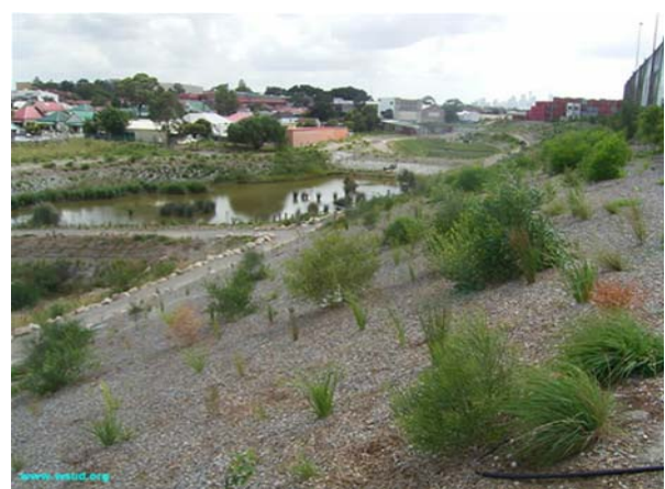
Figura 310. Lagoas de bio-retenção (alagados) – WSUD
