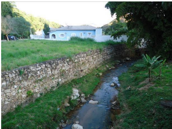
Figura 197. Trecho do Córrego Monte Alegre já na área Urbana da sede do município de Monte Alegre do Sul
