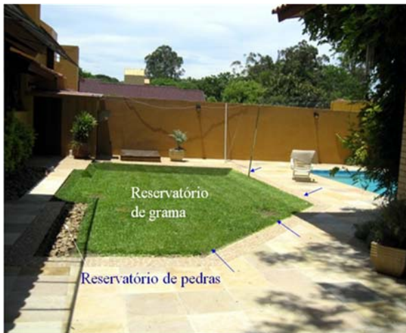
Figura 305. Mini bacia residencial de retenção com sistema de infiltração
