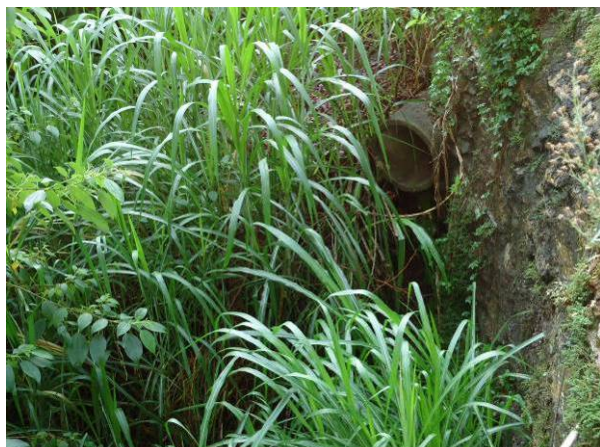
Figura 224. Vista do ponto de lançamento de água pluvial P11
