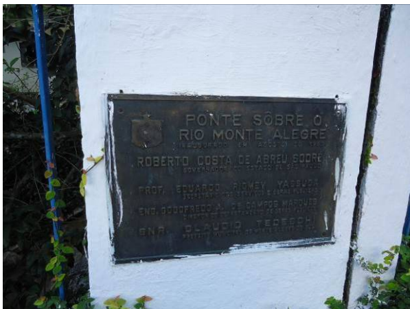
Figura 199. Placa da obra da ponte que atravessa o Córrego Monte Alegre
