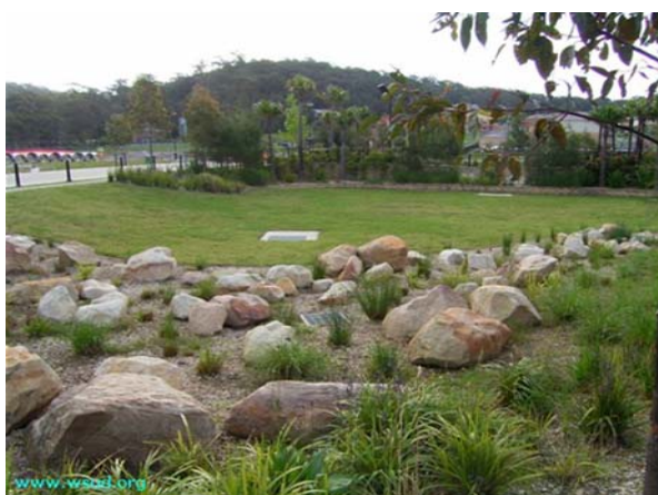
Figura 309. Bacia de bio-retenção – WSUD
