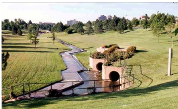
Figura 313. Reservatório de retenção seca construída no Wallace Park, Denver-USA, utilizado para controle de enchentes, e recreação no período seco
