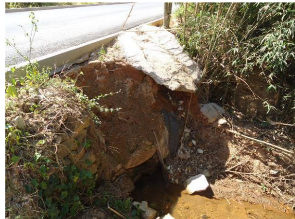
Figura 221. Vista do ponto de lançamento de água pluvial P8
