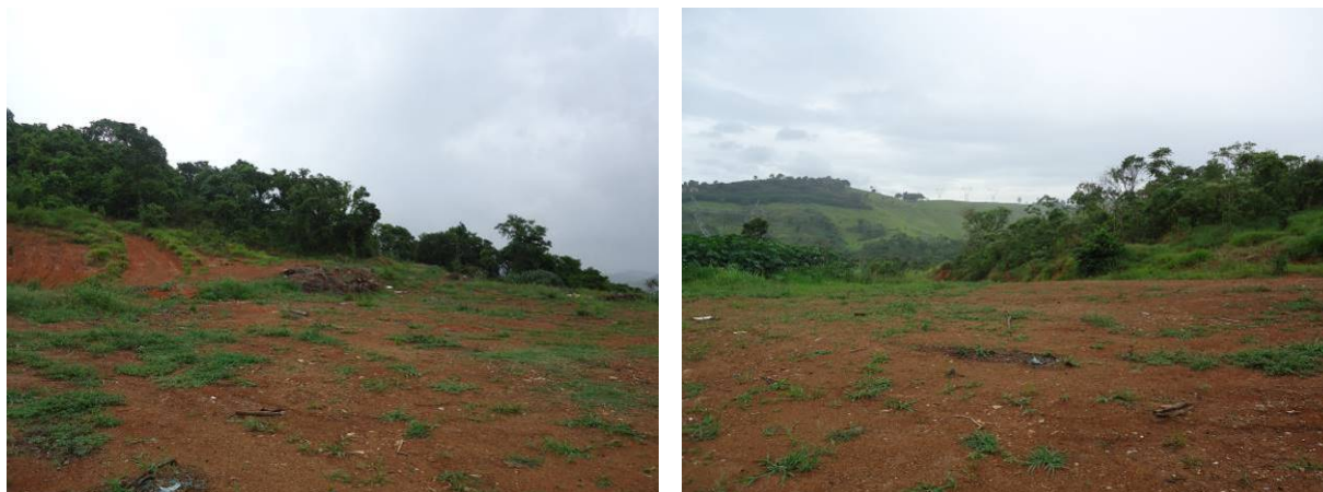
Figura 255. Terreno da prefeitura situado no bairro do Falcão onde eram despejados os resíduos de poda e supressão
