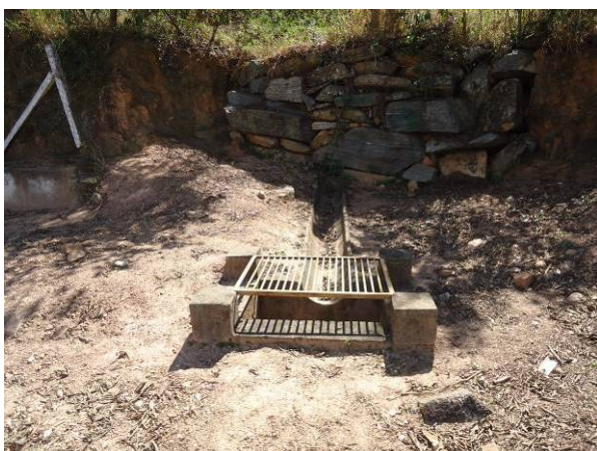
Figura 207. Canaleta de Águas Pluviais e Boca de lobo
