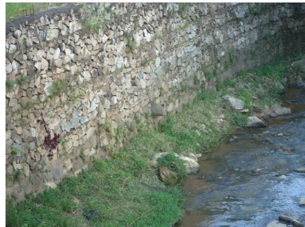
Figura 215. Vista do ponto de lançamento de água pluvial P2
