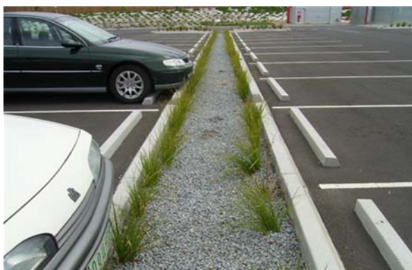
Figura 293. Trincheira de infiltração em estacionamento
