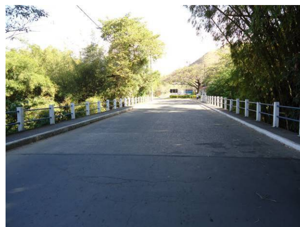
Figura 206. Ponte sobre o rio Camanducaia na Av. Viriato Valente
