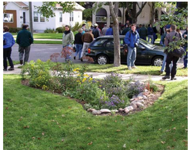
Figura 306. Bacia de bio-retenção em área pública (Jardim de Chuva)
