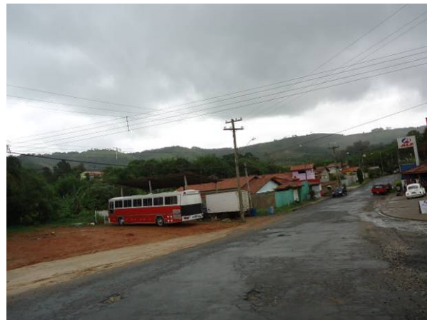
Figura 233. Área de alagamento no Bairro Ponte Preto
