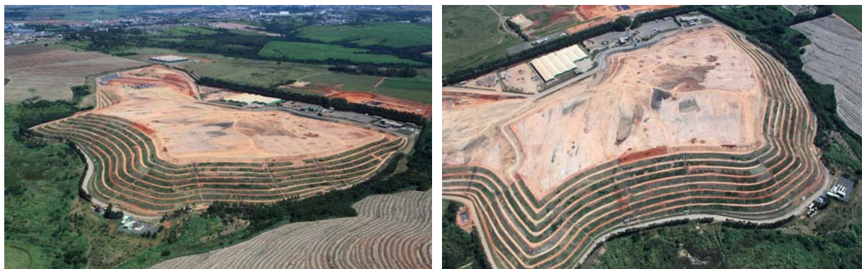
Figura 263. Vista do aterro sanitário de Paulínia
