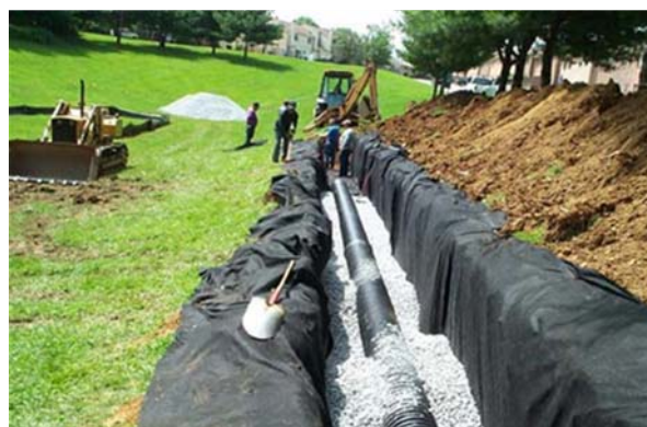
Figura 294. Construção de trincheira de infiltração
