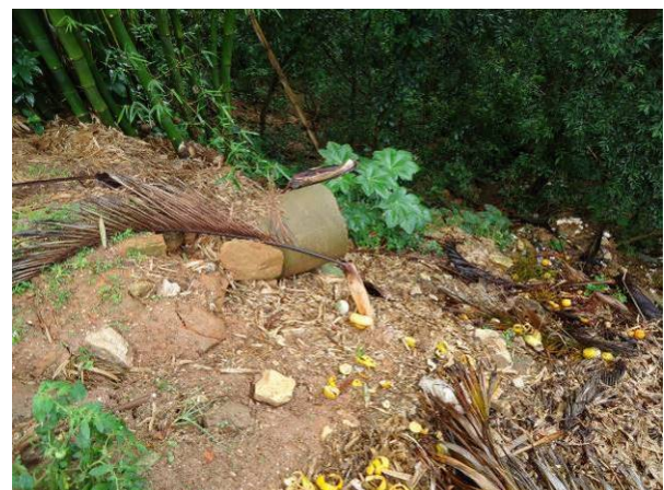
Figura 223. Vista do ponto de lançamento de água pluvial P10
