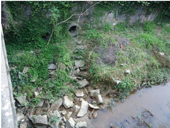
Figura 218. Vista do ponto de lançamento de água pluvial P5
