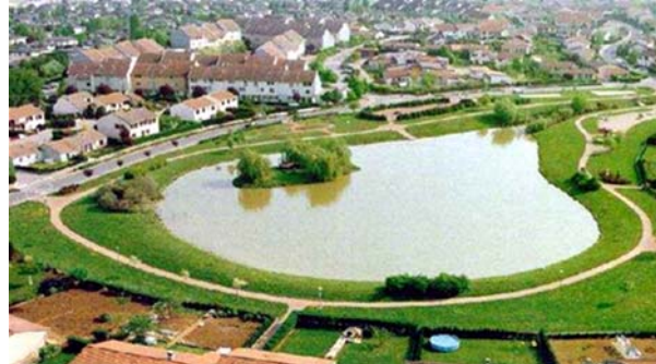
Figura 312. Bacia de retenção alagada com volume de espera para controle de enchente e áreas de recreação e lazer
