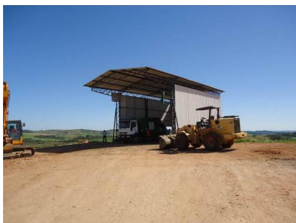
Figura 268. Vista da área de transbordo
