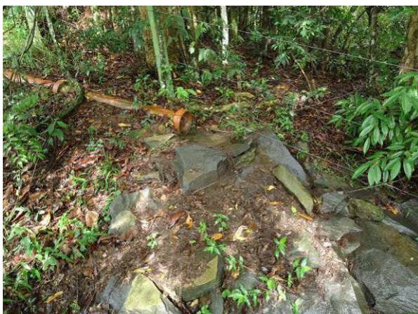
Figura 222. Vista do ponto de lançamento de água pluvial P9
