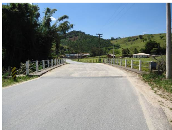
Figura 204. Ponte sobre o rio Camanducaia no Bairro Falcão
