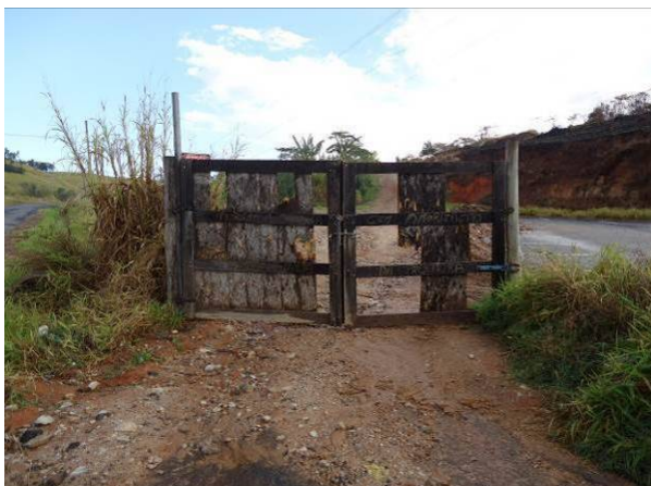
Figura 247. Entrada do antigo depósito de resíduos de construção civil
