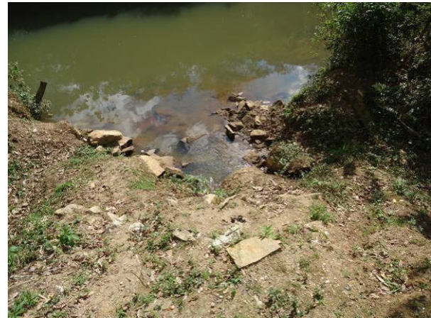
Figura 219. Vista do ponto de lançamento de água pluvial P6
