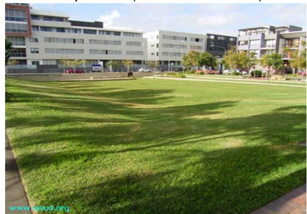
Figura 308. Bacia de bio-retenção – WSUD
