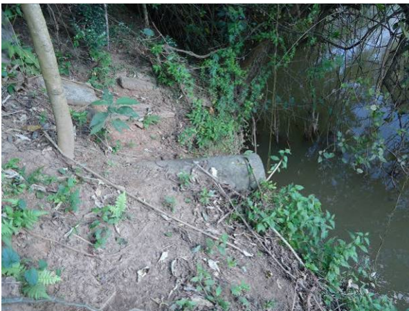
Figura 214. Vista do ponto de lançamento de água pluvial P1
