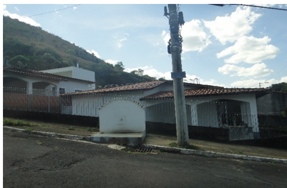
Foto 4-46: Exemplo de boca de lobo em via com pavimentação asfáltica.
