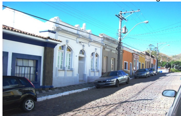
Foto 4-20: Edificações implantadas sem afastamento frontal e lateral, destaca-se o bom estado de conservação das fachadas.
