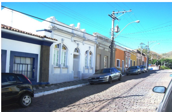
Foto 4-47: Pavimentação de via da área central em paralelepípedo em bom estado de conservação.
