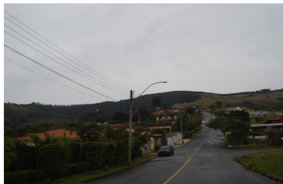
Foto 4-48: Vista de via com pavimentação asfáltica, destaque para a porção direita sem delimitação e pavimentação adequada da calçada.
