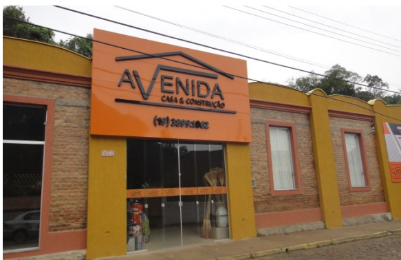
Foto 4-11: Vista de uma edificação de uso comércio na área central de Monte Alegre do Sul.
