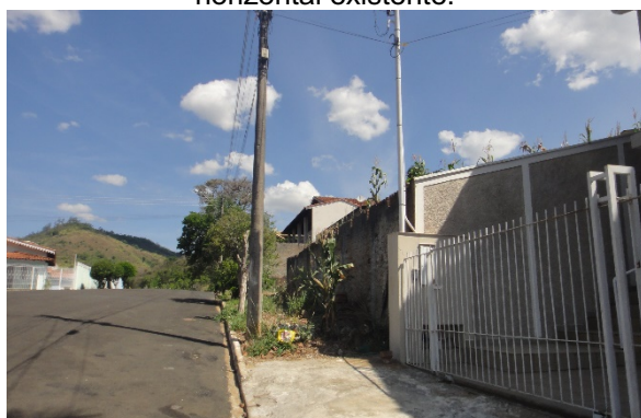
Foto 4-51: Exemplo de calçada com condições físicas inadequadas.
